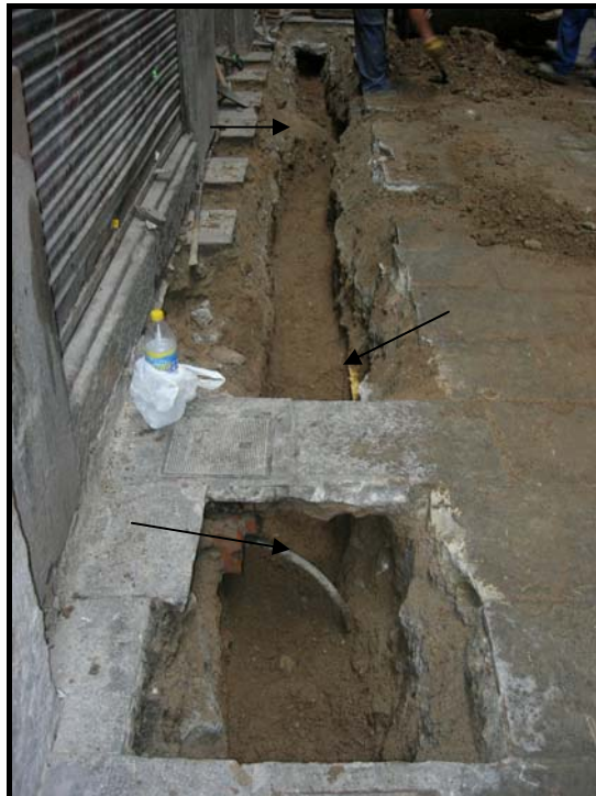
6. Últim tram de la rasa. S'aprecien nombrosos serveis d'aigua, llum i gas.
