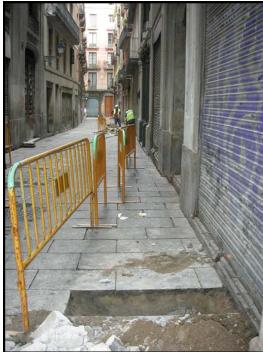
2. Vista del carrer amb la cata realitzada. Inici dels treballs al fons.
