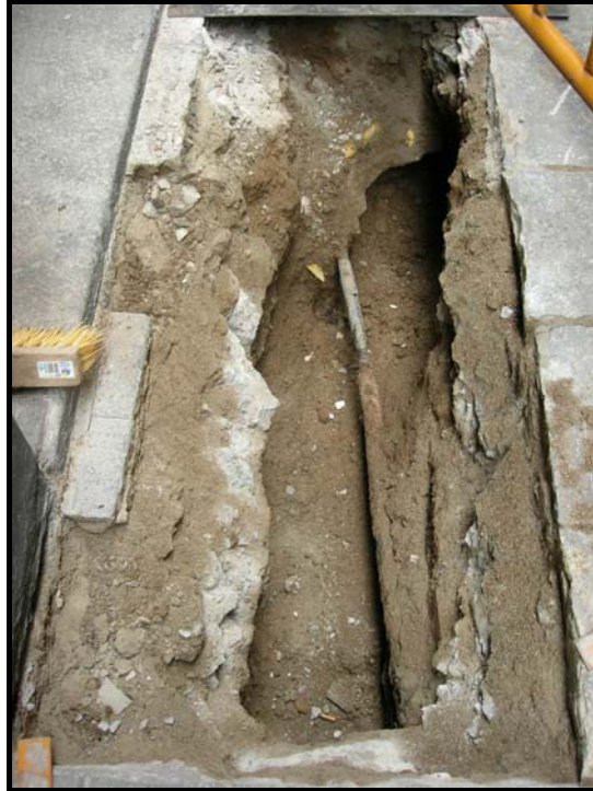
5. Localització de serveis elèctrics al primer tram de la rasa.
